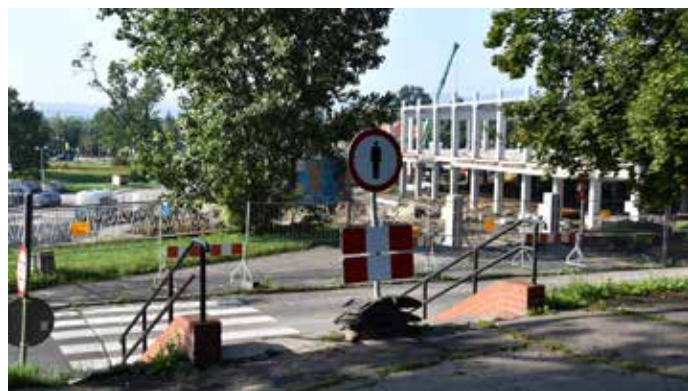
Budowę 2-poziomowego obiektu rozpoczęto w marcu 2022 r.
