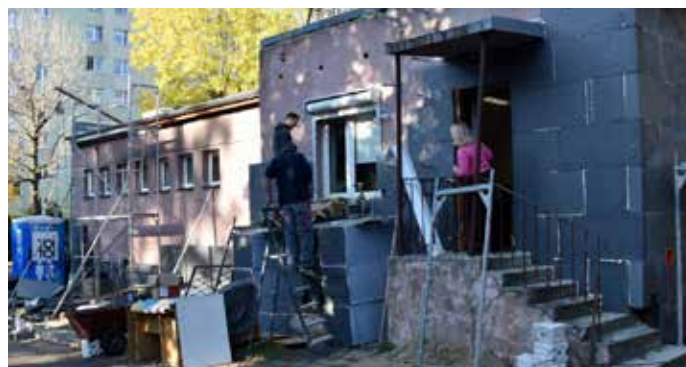
W Przedszkolu Publicznym nr 2 i Przedszkolu Publicznym nr 3 przeprowadzono w 2022 r. termomodernizację
