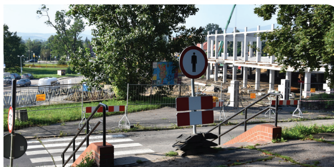
Po zakończeniu prac przy naprawie muru oporowego miasto przystąpi do remontu drogi
